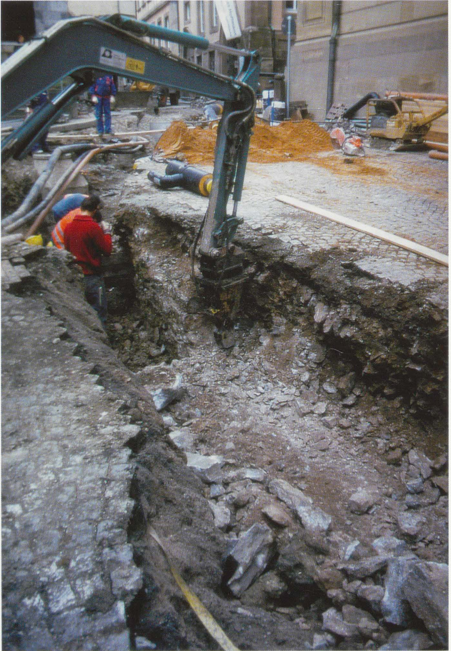
Abb. 6 Verlegung der Fernwärmeleitung am Hafenmarkt 1998. Mauerausbruch am Westabschluss von St. Jakob.
