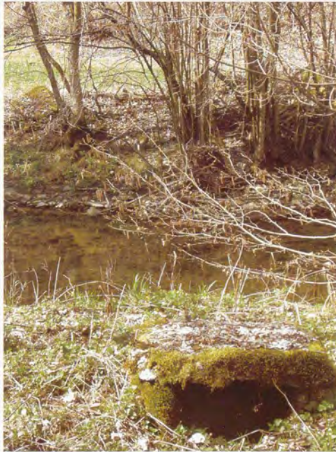
Abb. 12 Siphon (linke Bachseite)
