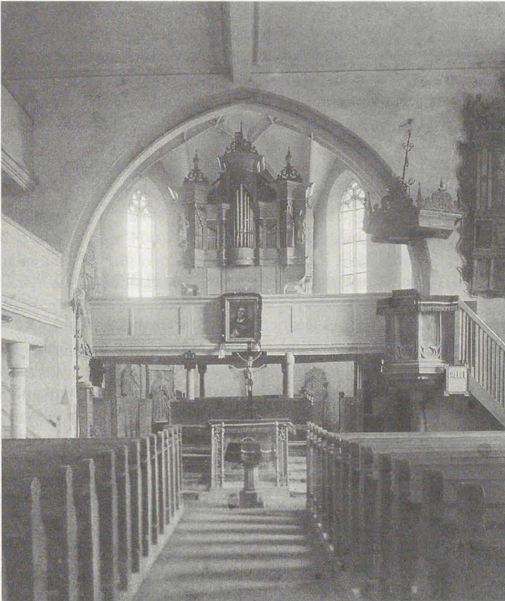
Abb. 5 Stephanuskirche Lendsiedel, Chor mit Orgelempore, Zustand bis 1957 (Foto ca. 1916) (Foto: Pfarrarchiv Lendsiedel).
