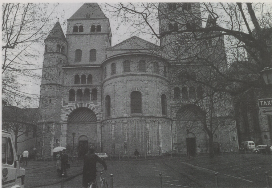
Abb. 24 Trier, Dom, Westbau. Foto der Verfasserin.
