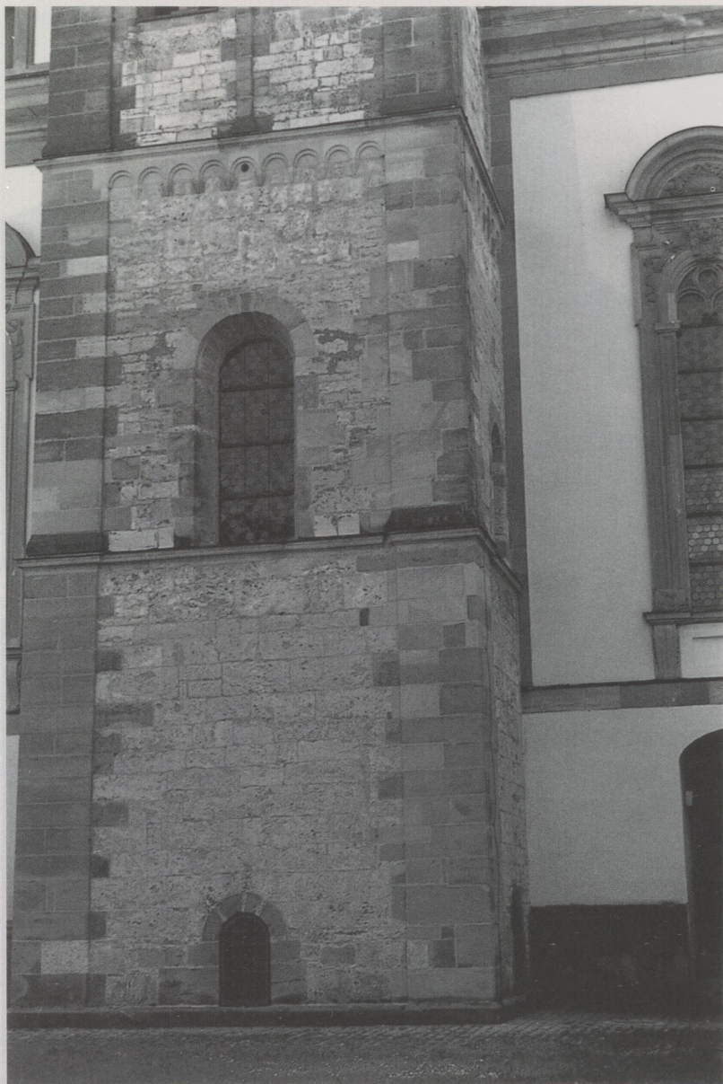
Abb. 12 a Großcomburg, ehem. Klosterkirche, unterer Teil des Westturms. Foto der Verfasserin.
