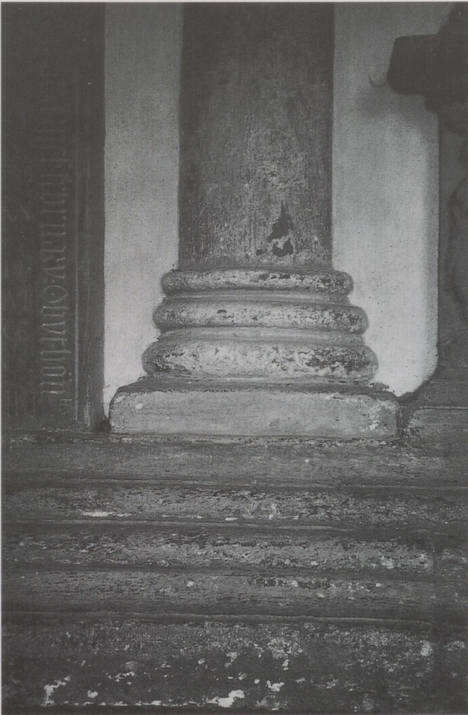
Abb. 18 Würzburg, Dom, Gebäudesockel und Halbsäulenbasis am südlichen Querhausarm (Kreuzgang). Foto der Verfasserin.
