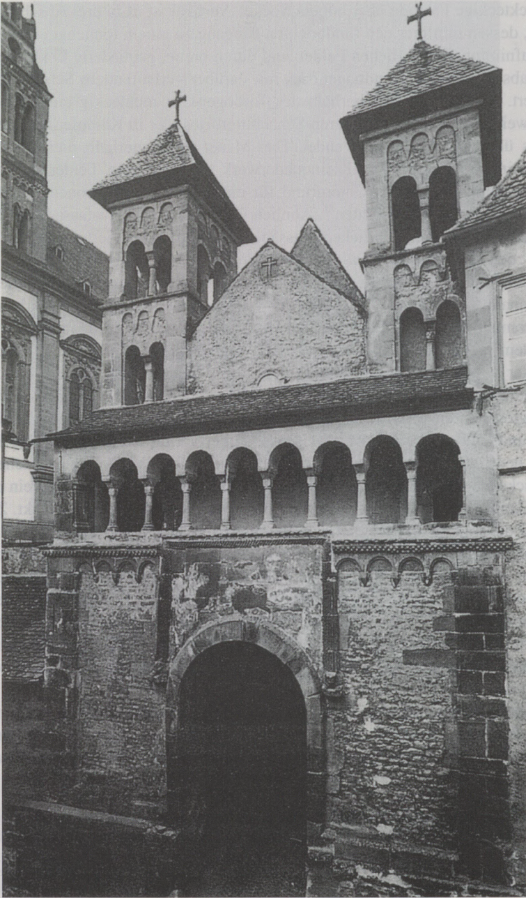
Abb. 22 Großcomburg, romanischer Torbau.
