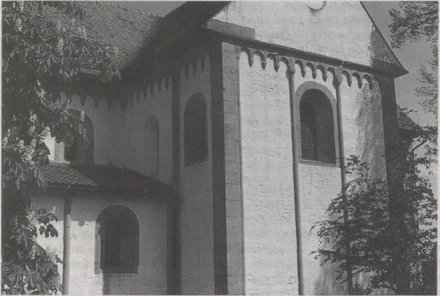
Abb. 19 Kleincomburg, südlicher Querhausarm. Foto der Verfasserin.
