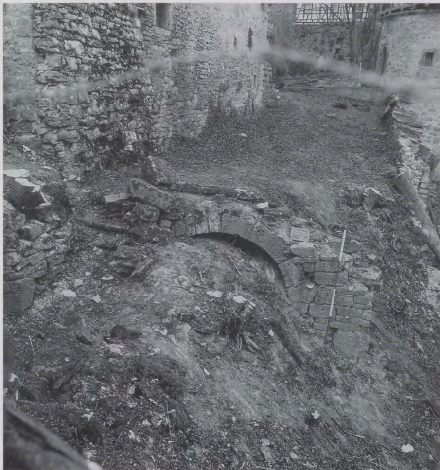
Abb. 4 Burg Amlishagen, Bereich zwischen Ostmauer und Archivgebäude nach Entfernung des Bewuchses, 1984 (Foto: Landesdenkmalamt Baden-Württemberg)
