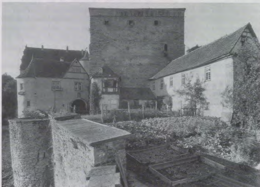
Abb. 1 Burg Amlishagen, Zustand 1933 (Foto: Landesbildstelle Baden-Württemberg)
