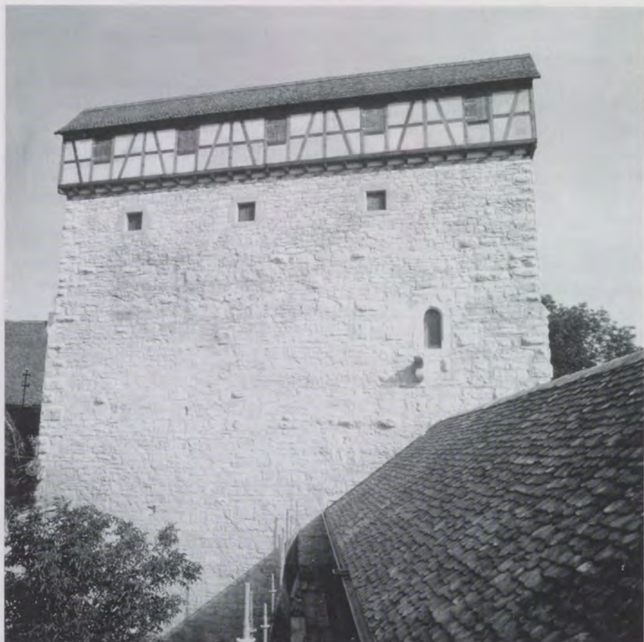
Abb. 6 Burg Amlishagen, Schildmauer nach der Sanierung, 1988 (Foto: Landesdenkmalamt Baden-Württemberg)
