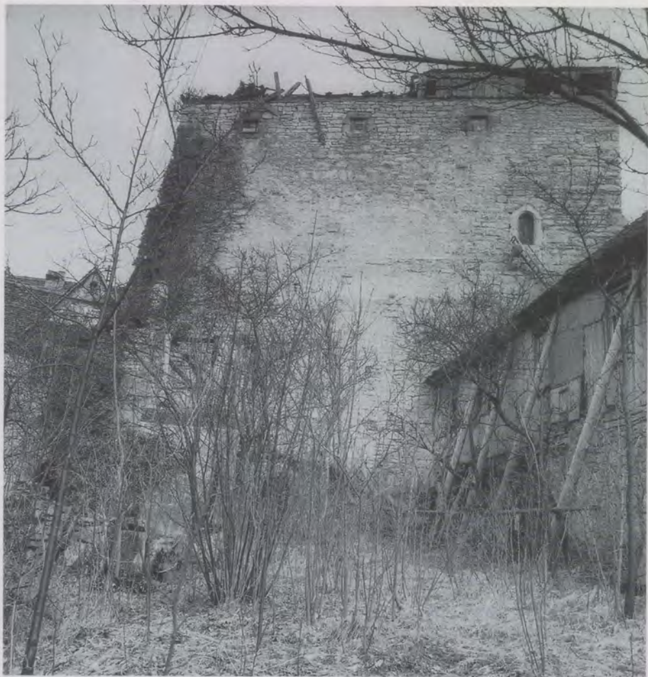
Abb. 5 Burg Amlishagen, Zustand 1982 (Foto: Landesdenkmalamt Baden-Württemberg)
