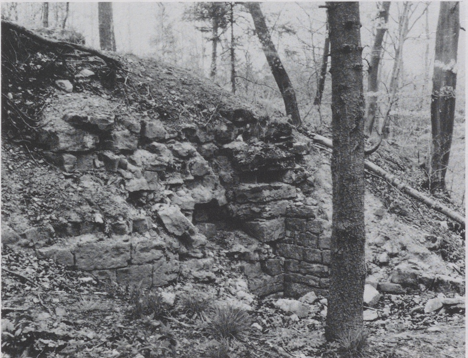
Abb. 13 ... der gleiche Mauerbereich heute
