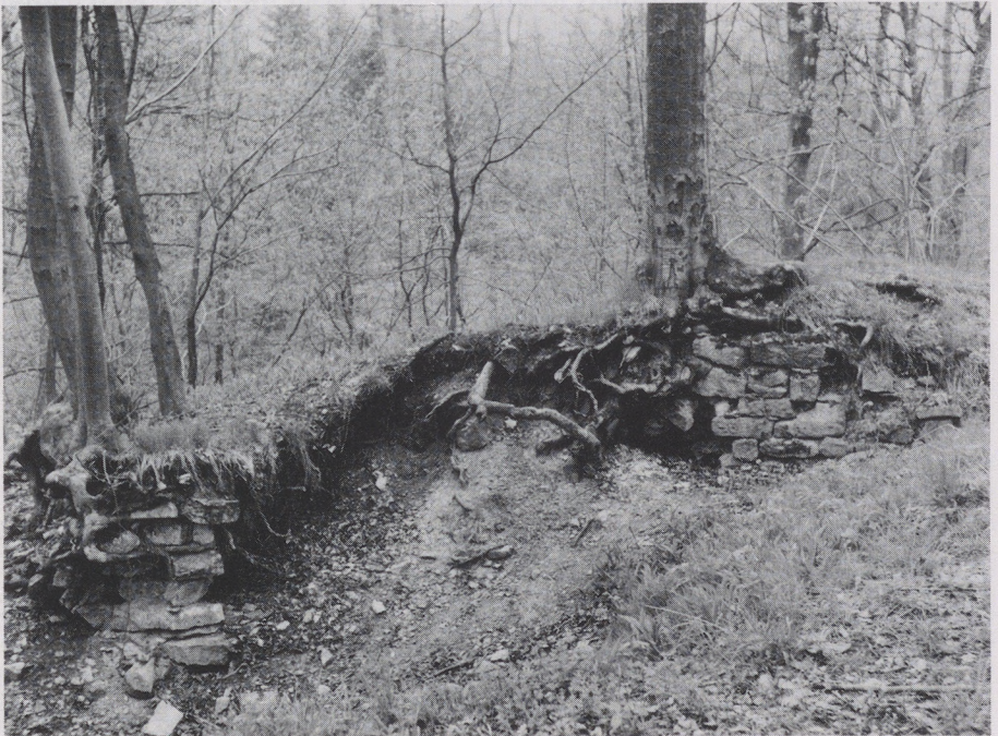
Abb. 17 Buchenwurzeln ist die Erhaltung von Mauerteilen zu danken (G. Stachel)
