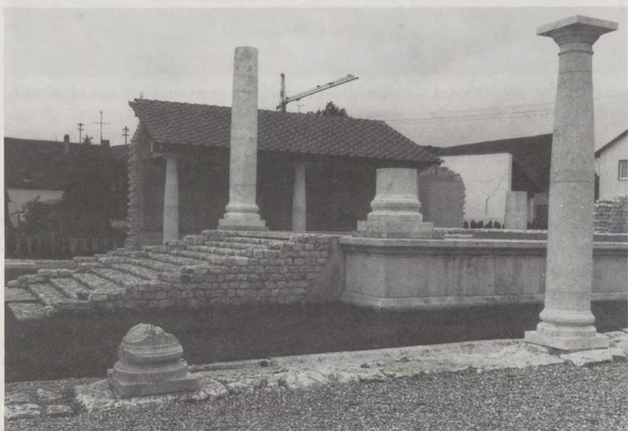
Abb. 6: Wiederhergestellte Aufgangstreppe und Podium für Pronaos und Cella des Apollo-Grannus-Tempels in Faimingen.
