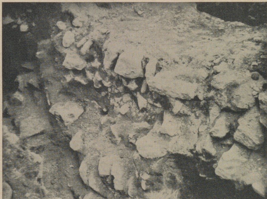
Abb. 5. Futtermauerwerk der Burg Criesbach auf dem Quelltuffhügel, bei III 3. (Aufnahme: Dr. G. Wieser)
