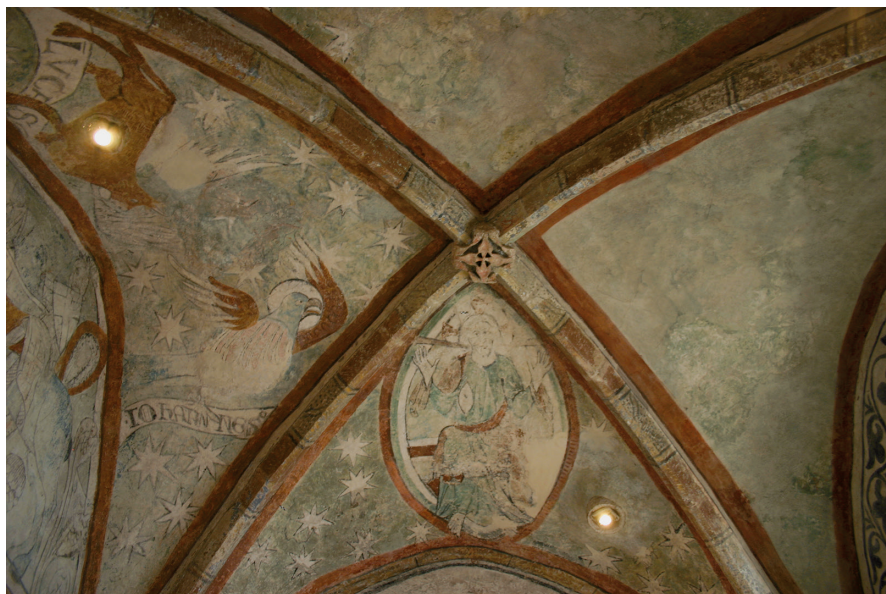
Abb. 8 Hollenbach, Gewölbe des ehemaligen Chors im Turm.
