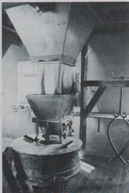
*Einzelner Mahlgang mit Läutevogel auf der Gosse. Rechts aushebbarer Kranthalgen mit Mühlsteinzange, unterm Fenster Stellrädern zur Wasserregulierung*
