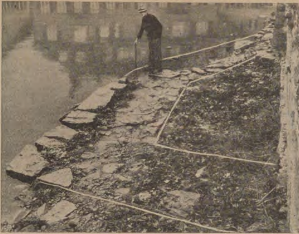
Abb. 48. Der Haaleckturm (21). Die Fundamentstärke ist durch weiße Linien gekennzeichnet, der Stock steht an der südwestlichen Ecke. [Aufnahme: Kaloumenos, Schwäb. Hall]
