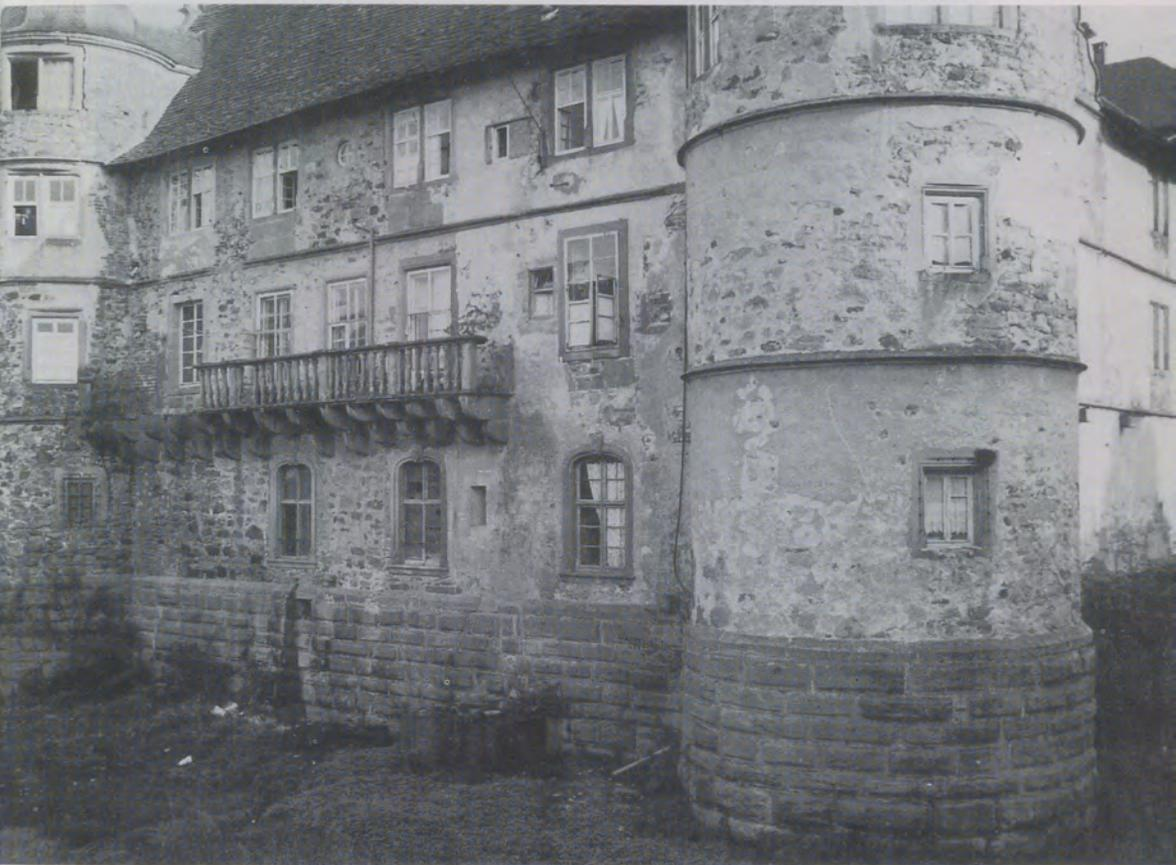
*Abb. 15 Schloß Pfedelbach, Nordflügel. Nur wenige Fenster wurden durch die begonnene Barockisierung verändert. Der Balkon wurde durch Artilleriebeschuß im April 1945 beschädigt. Der Quadersockel reicht noch tief in die Grabenauffüllung hinunter. Aufn. W.-G. Fleck 1962*
