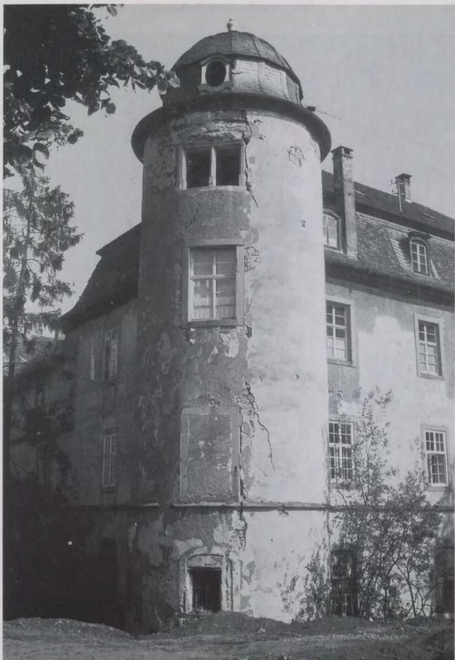
*Abb. 17 Schloß Pfedelbach, Südflügel und Südwestturm. Im obersten Turmgeschoß blieb das Renaissancefenster erhalten. Es sollte so durch einen Stuckrahmen kaschiert werden, wie das mit dem ebenfalls alten Erdgeschoßfenster geschah. Durch das Einbrechen der großen Fenster entstanden starke Risse. Aufn. W.-G. Fleck 1962*
