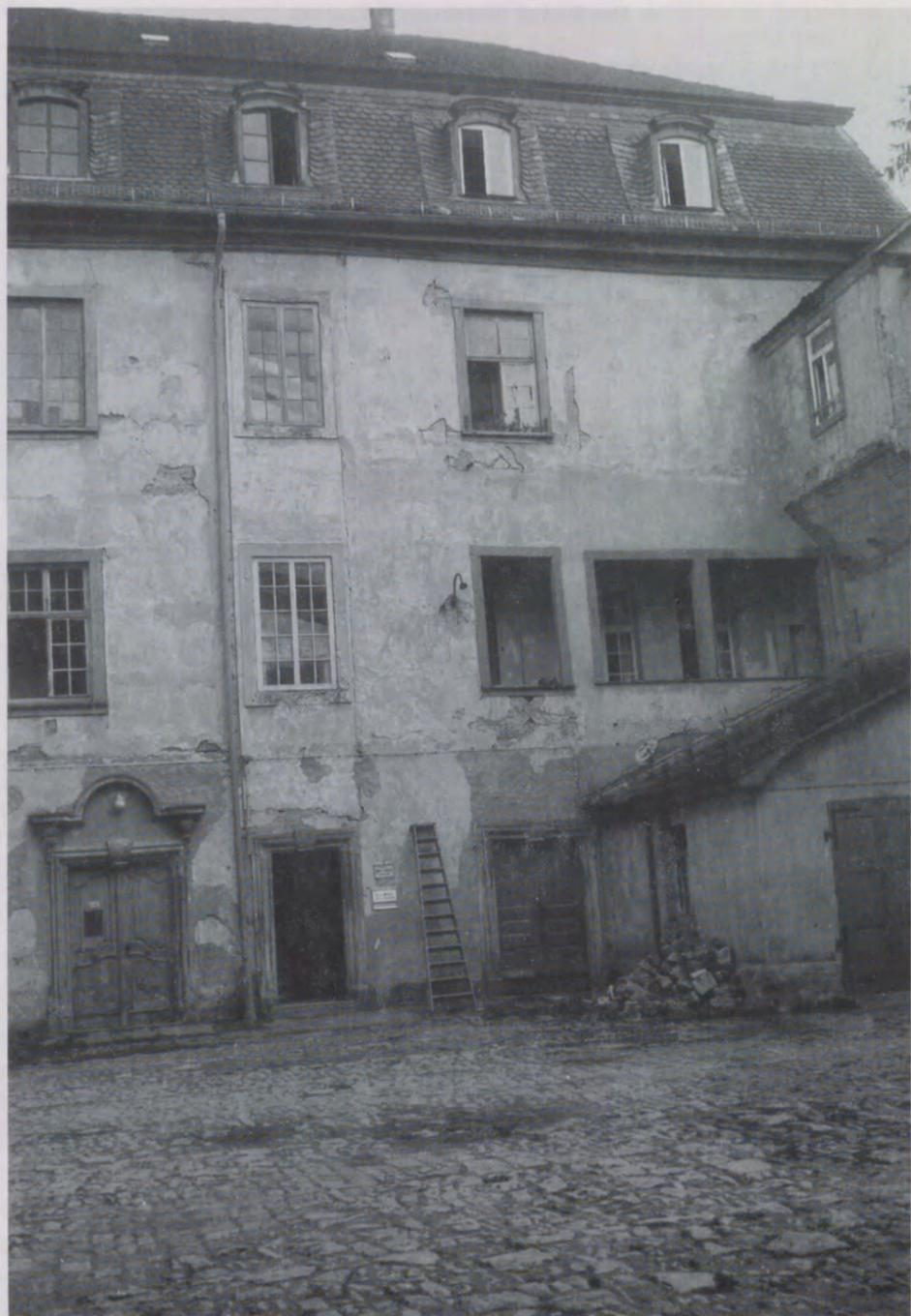
Abb. 20 Schloß Pfedelbach, Südflügel, Hofseite. Durch die begonnene Barockisierung ist der Treppenturm in der Fläche des vorgelegten Ganges und unter dem Mansarddach verschwunden. Hinter den Fenstern sind die Läufe der Wendeltreppe zu sehen. Die Loggia und die Vorbauten sind 19. und 20. Jahrhundert. Aufn. W.-G. Fleck 1962
