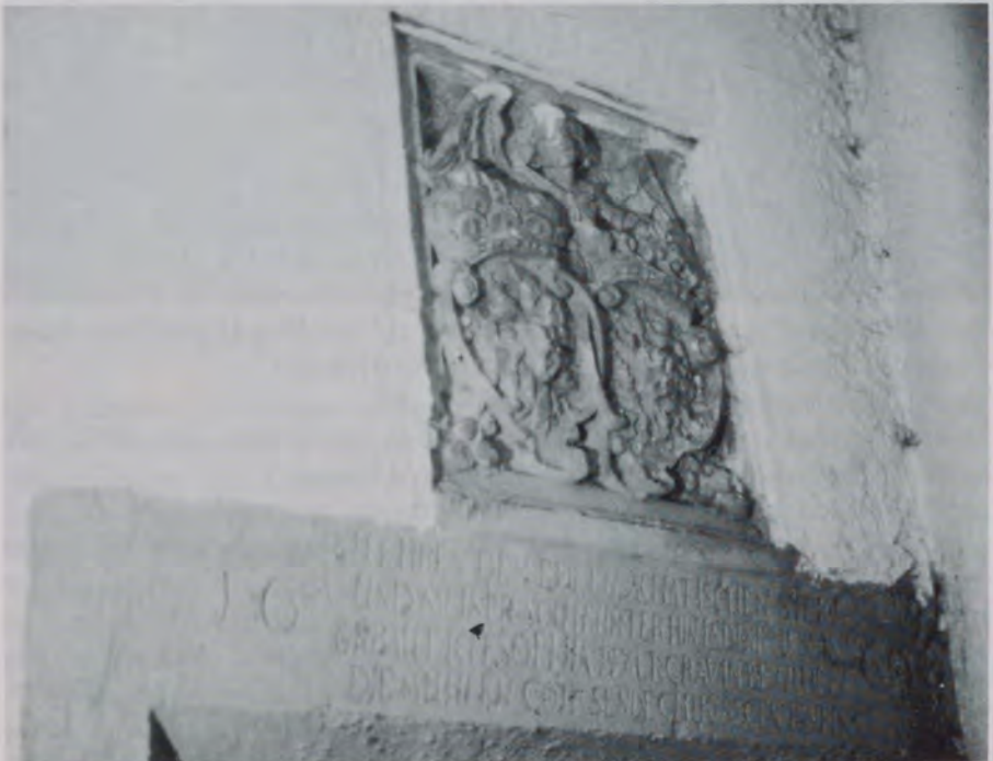
Inskrift über dem alten Treppenaufgang von 1669
