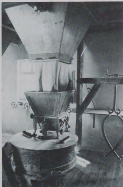
Einzelner Mahlengang mit Läutevogel auf der Gosse. Rechts aushebbarer Kranthalgen mit Mühlsteinzange, unterm Fenster Stellrädern zur Wasserregulierung
