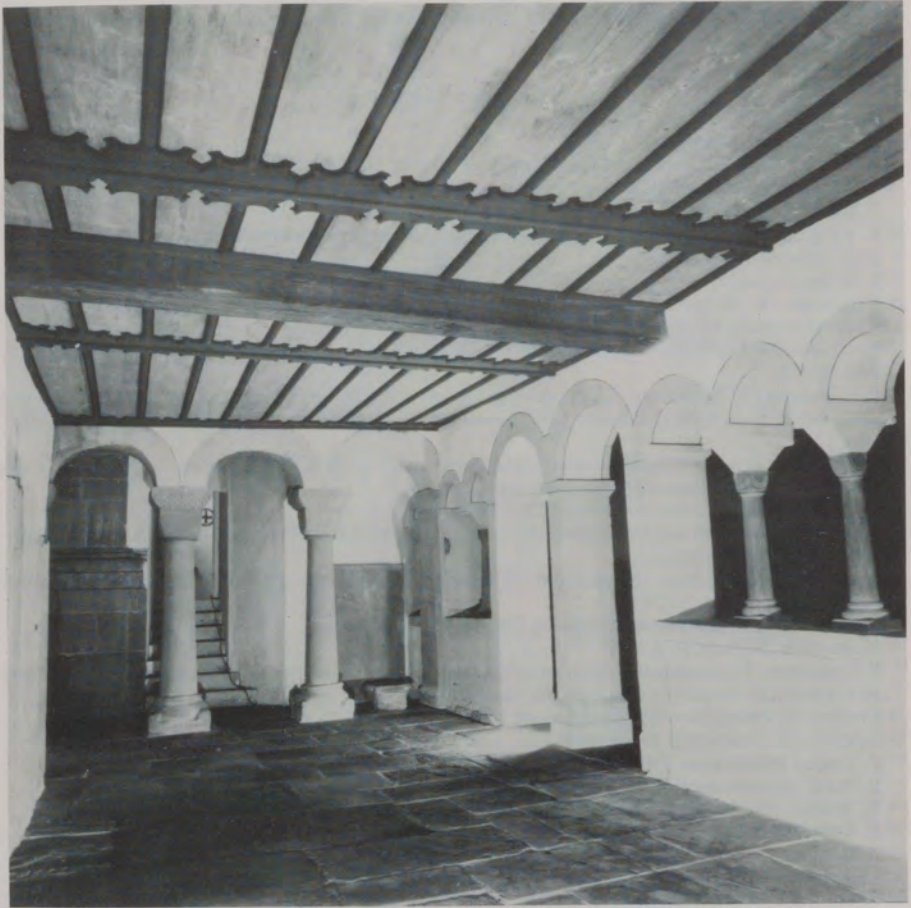
Abb. 4 Vorraum zum Kapitelsaal mit gotischer Bretterdecke.
