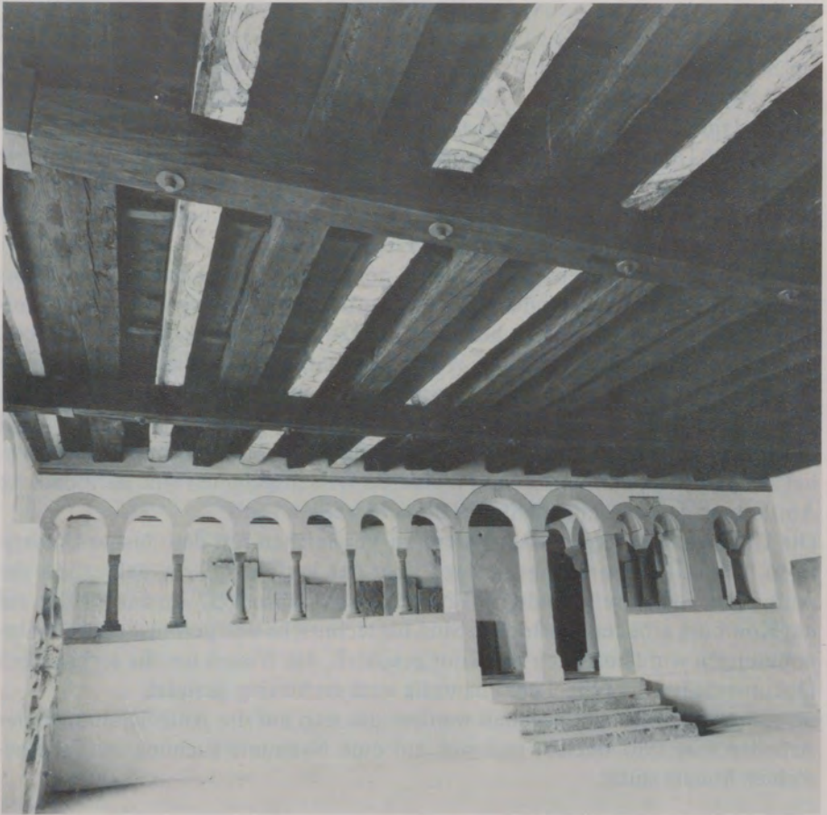
Abb. 1 Der romanische Kapitelsaal mit Blick nach Westen (Vorraum).
