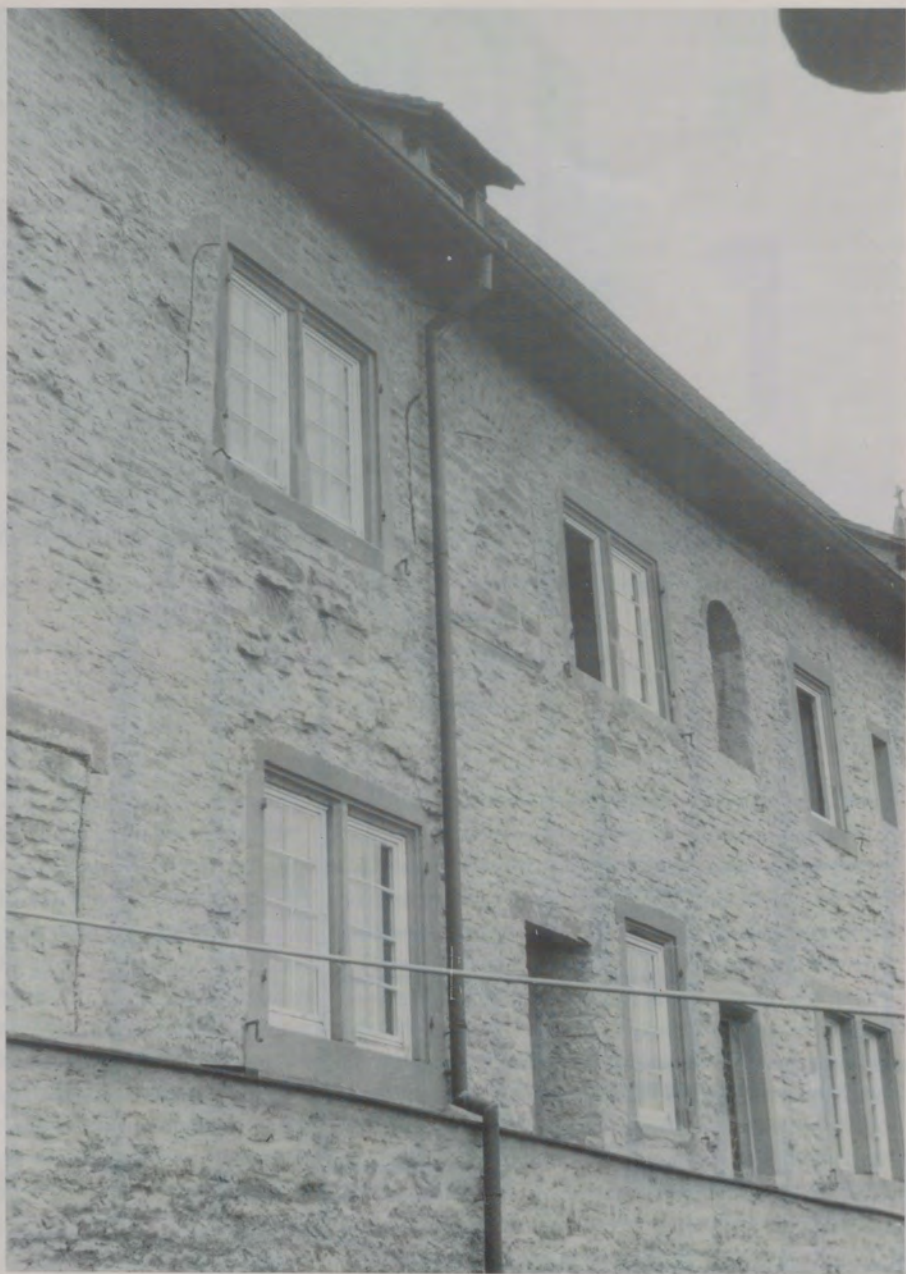
Abb. 3 Klausur-Südtrakt (Gr. Vikarienbau) von Süden mit freigelegten romanischen Fenstern in beiden Geschossen.
