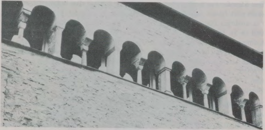
Großkomburg, Abtshaus. Fensterarkaden.
