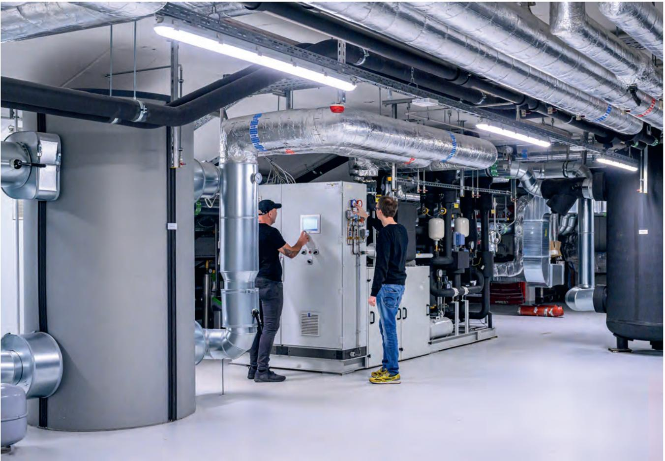
An der Kälte- und Wärmepumpe in der Technikzentrale können die Temperaturen im Gebäude abgelesen und der Jahreszeit entsprechend reguliert werden.
