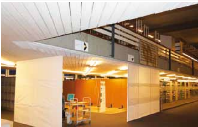
Abb. 1: Umbau des Selbstabholerbereichs
