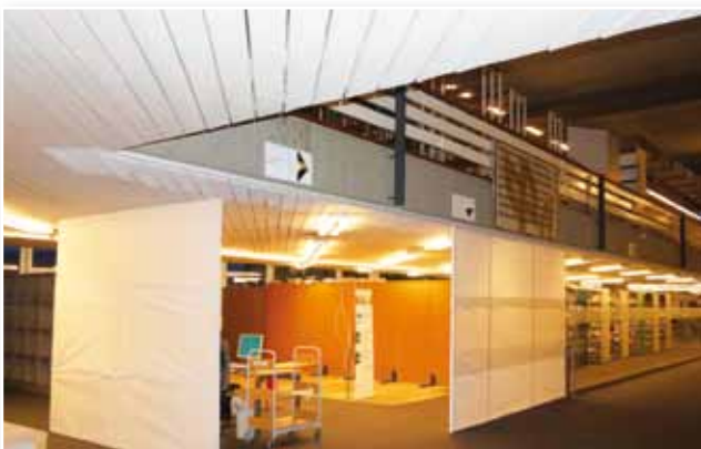
Abb. 1: Umbau des Selbstabholerbereichs
