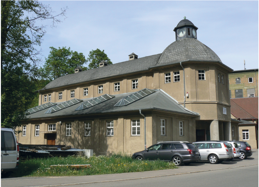
Abb. 7: Wasch- und Umkleidegebäude von 1913/1914 (Neckartal 159).
