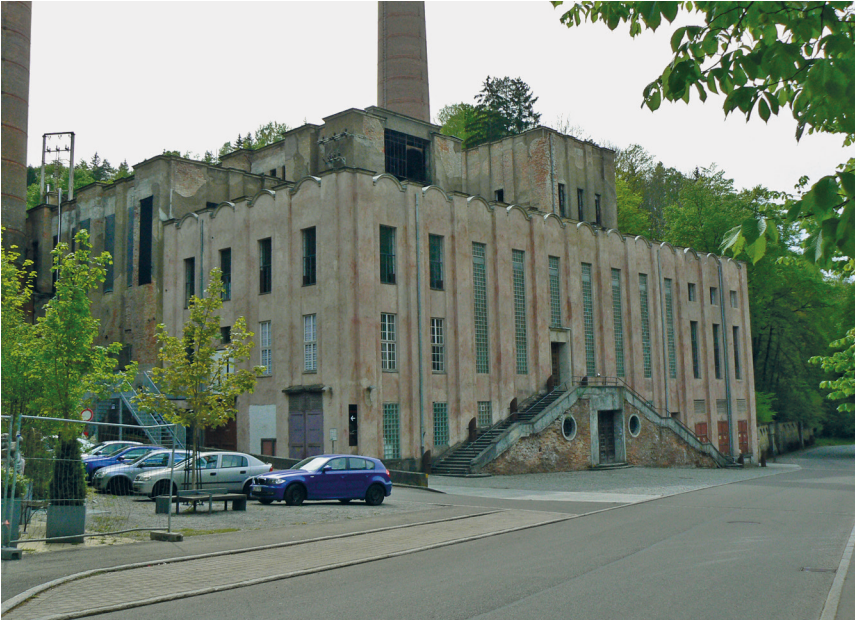
Abb. 9: Kraftwerk von 1916 (Neckartal 68).
