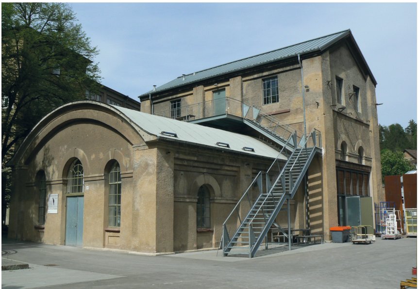
Abb. 4: Pumpenhaus von 1889/1890 (Neckartal 207).
