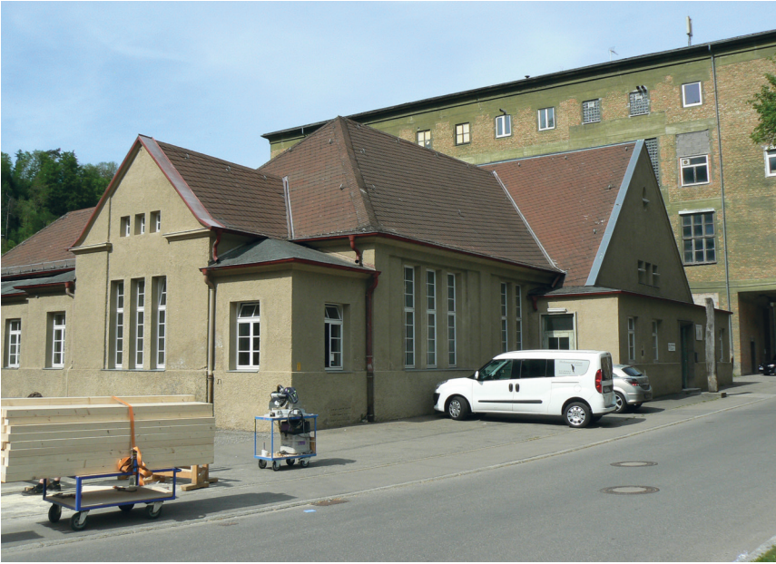
Abb. 5: Arbeiterkantine von 1909/1915 (Neckartal 161).
