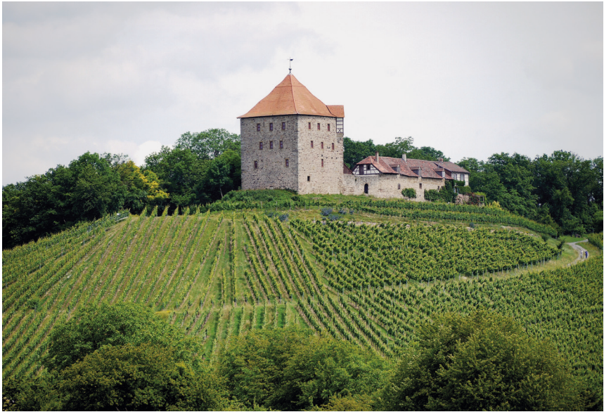
Abb. 7: Burg Wildeck von Südwesten (Aufnahme: H. Ehmer).
